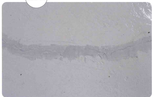
補修例(クラック補修)
